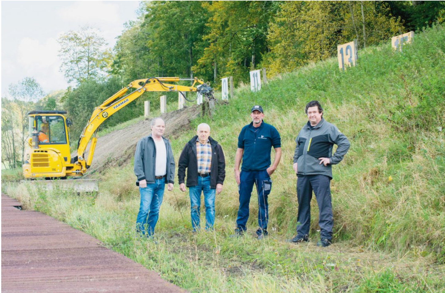
Christian Burri (erster von links), Heinz Burkhalter (zweiter von links) und ihre Schützenkollegen nehmen mit gemischten Geföhlen vom Baubeginn Kenntnis. YANN STAFFELBACH
