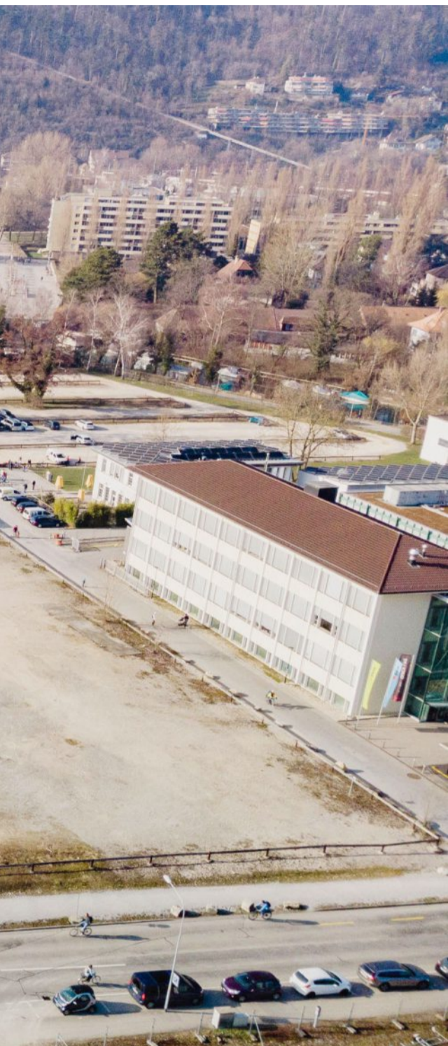
Wo heute Boote eingewintert werden, sollen künftig Wohnungen stehen: Agglolac wird auf dem ehemaligen Expo-Areal in Nidau geplant. MATTHIAS KÄSER
